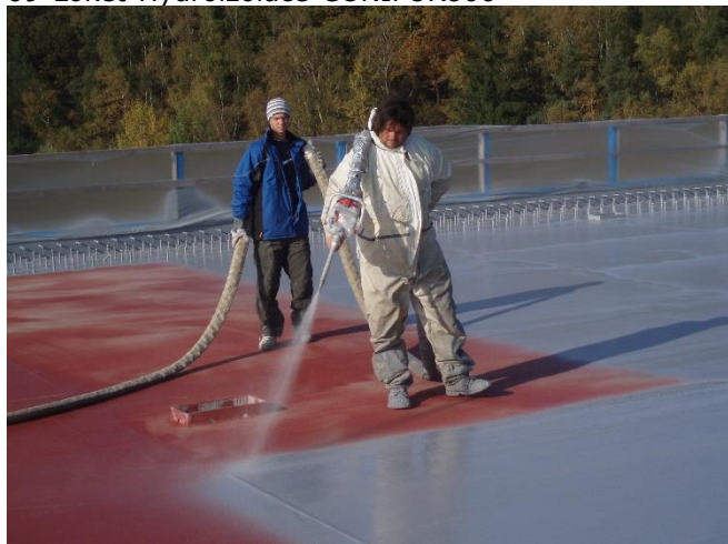
09-Loket-Hydroizolace-CONIPUR800
