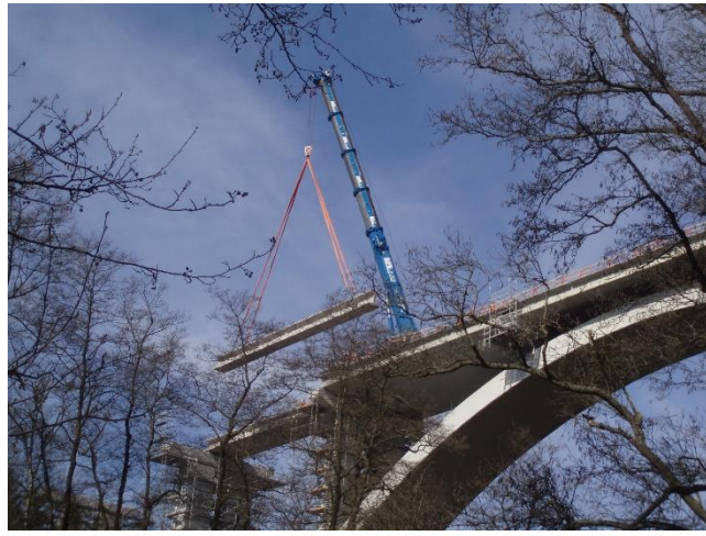
04-Loket-Demontáž nosníků I67
