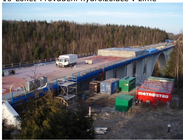
10-Loket-Provádění hydroizolace v zimě
