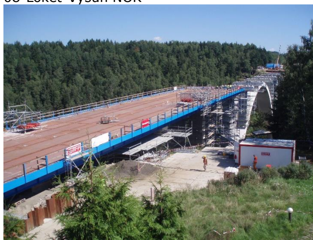
10-Loket-Provádění hydroizolace v zimě
